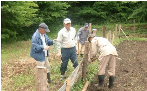
イノシシ防護柵補修作業
