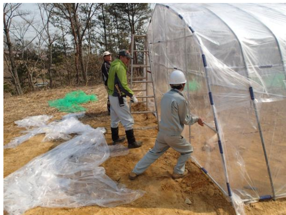
3/12. ビニールハウス修理風景
