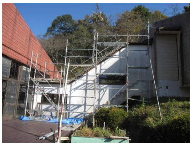
屋根塗装のため足場組み立てた
