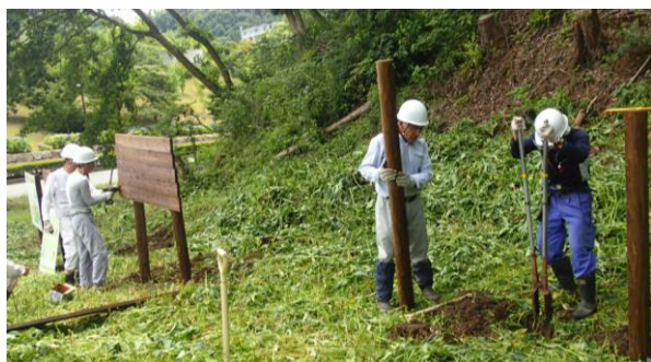
看板取り付け作業
