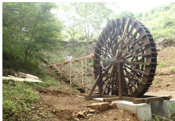
直径3mの水車です(発電機を取付ける予定です)
