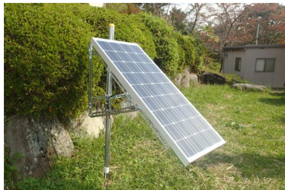
太陽光発電パネルです(出力90W) 発電量と太陽光の関係を学べる施設です (太陽の方向や角度を調整できる)
